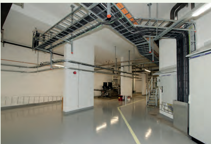
Vamma 12 har vært et teknisk krevende prosjekt med skyhøye krav til presisjon.
