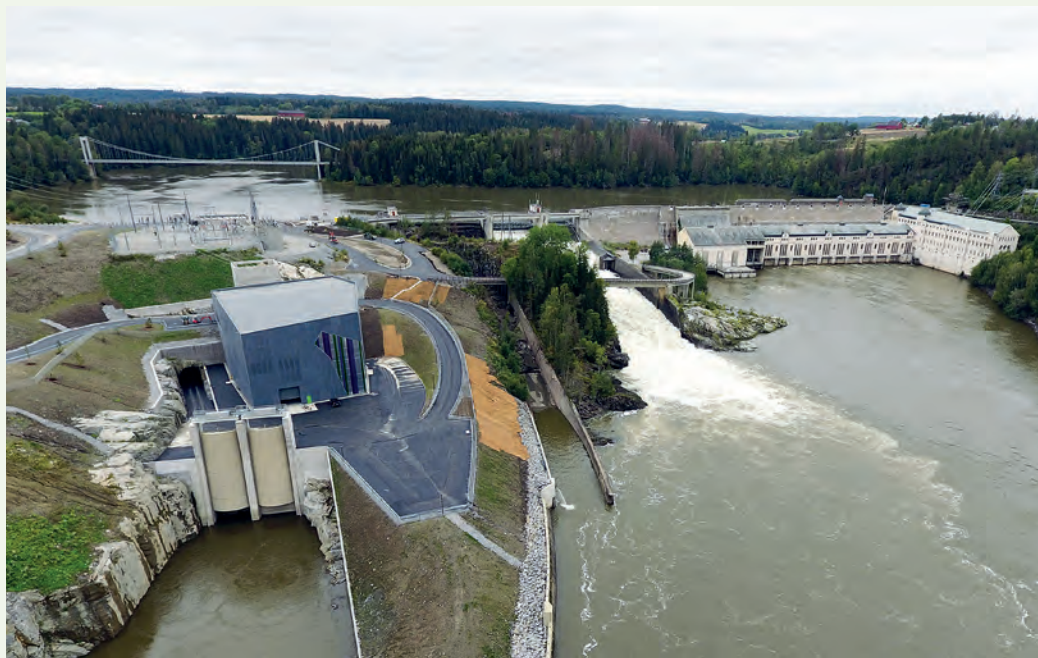
Vamma 12 utgjør en kraftig økning i slukeevne og kraftproduksjon ved kraftverket.
