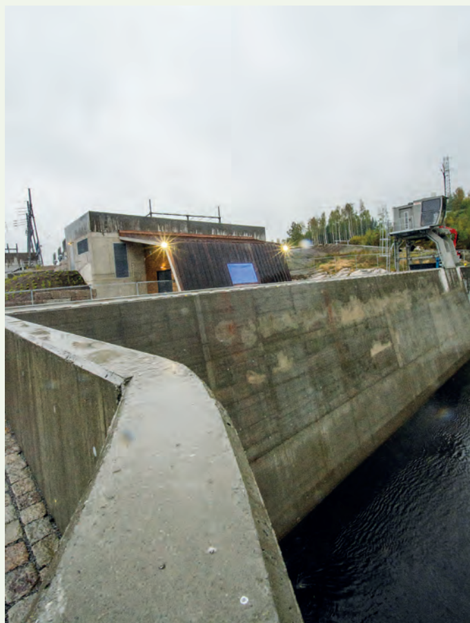
Det er bygget et nytt vanninntak og en ny kraftstasjon.
