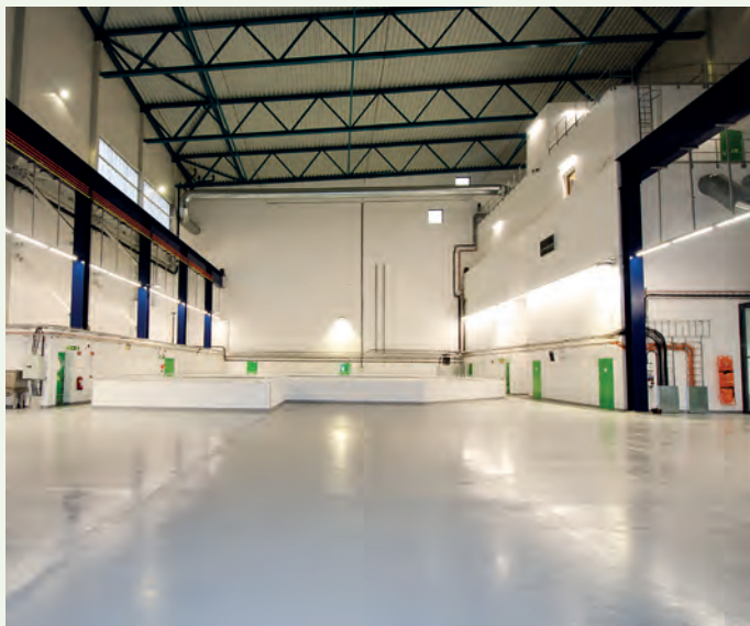
Montasjehallen og maskinsalen gir god plass til lagring og utskifting av store bestanddeler av kraftverket, hvis nødvendig.
